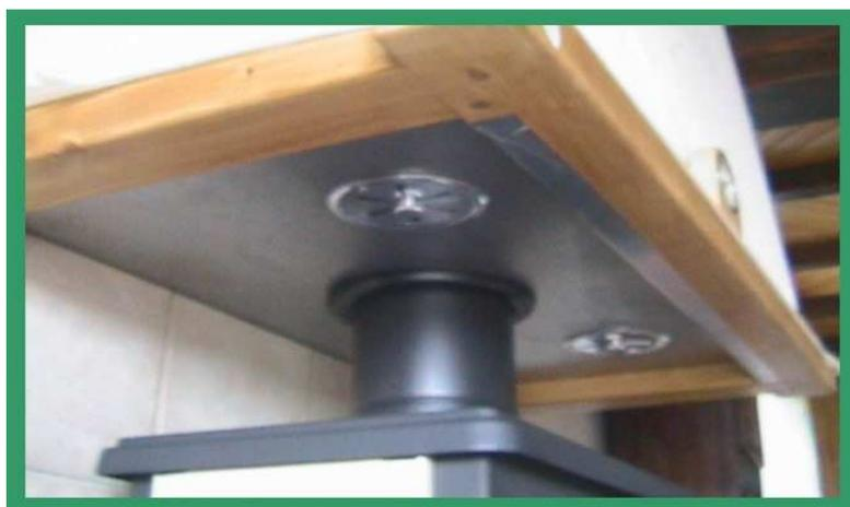
La hotte est fermée par une plaque d'alu de 5 mm dans laquelle sont aménagés 3 passages : 1 trou central de 180 mm (conduit de fumée) et deux de 100 mm (bouches de ventilation).
